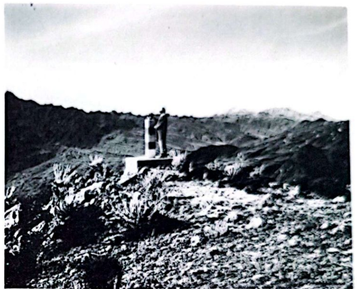
Figura 33. Aspecto general de una estación geodésica, durante una medición de ángulos en el sistema grande de la región de Mucubají (Estación El Gavilán I, 4.060 m. de elevación). Nótese los picos nevados de Humboldt, Bonpland y Pico Bolívar en el fondo a la izquierda.
